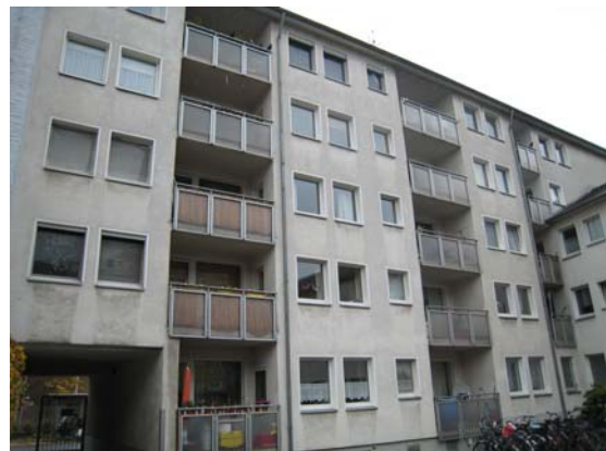
Wöhlerstrasse, Köln. Bygget 1960 med 1.640 m 2 og 31 lejemål.
