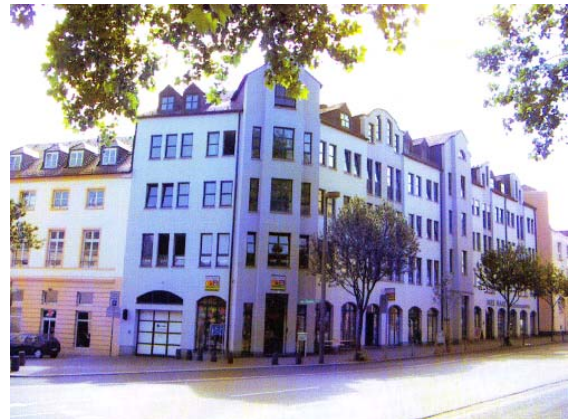
Weissliliengasse 10 m.fl., Mainz. Bygget 1954 med 3.035 m 2 og 31 lejemål.
