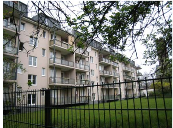
Kalküerstrasse 32-40 m.fl., Düsseldorf. Bygget 1960 med 2.000 m 2 og 30 lejemål.
