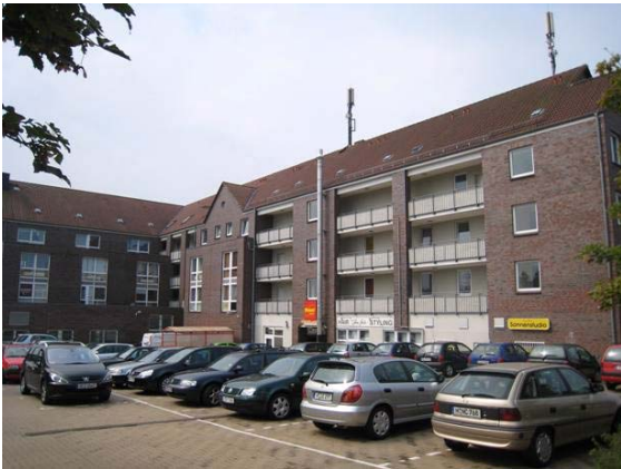
Tresckowstrasse 187 m.fl., Hannover. Bygget 1992 med 3.575 m 2 og 36 lejemål.
