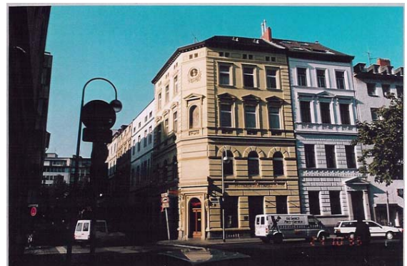
Hildeboldplatz 1a, Köln. Bygget 1890 med 483 m 2 og 10 lejemål.
