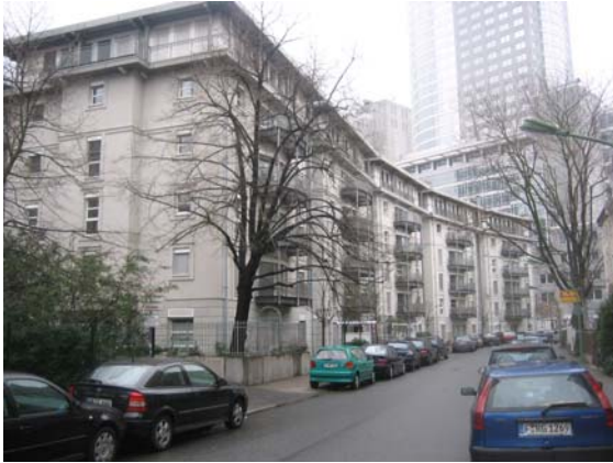
Nidenau 2, Frankfurt. Bygget 2005 med 1.660 m 2 og 25 lejemål.
