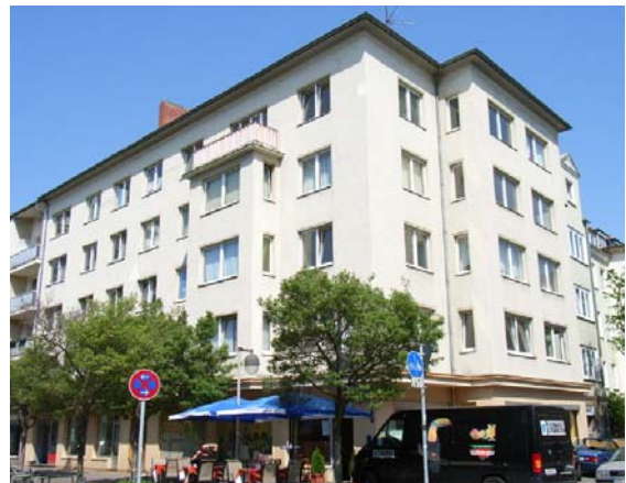
Lange Laube 24, Hannover. Bygget 1954 med 1.771 m 2 og 19 lejemål.
