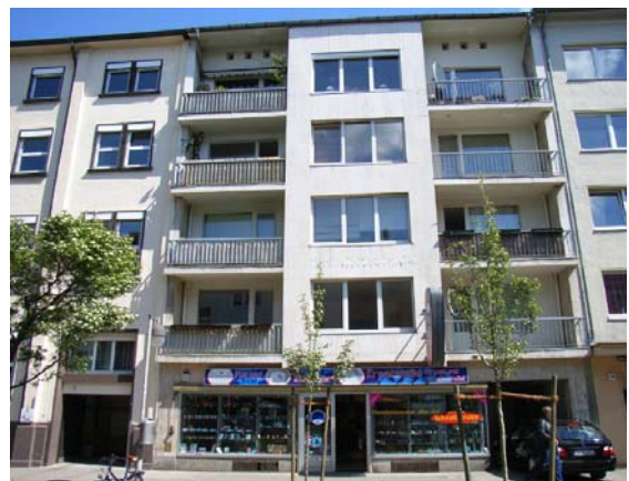
Lange Laube 26, Hannover. Bygget 1954 med 823 m 2 og 10 lejemål.
