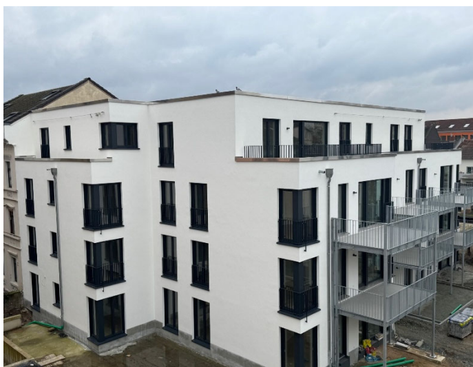
Nybyggeri Austraße 43a, Offenbach am Main
