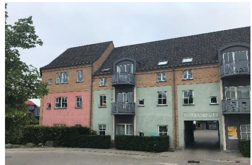
Hillerød – Slotshusene 1-3 Byggeår 1997 77 boliger fordelt på 4.217 m 2
