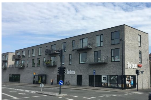
Birkerød – Teglpørtten 21-23 Byggeår 2012 24 boliger fordelt på 2.931 m 2
