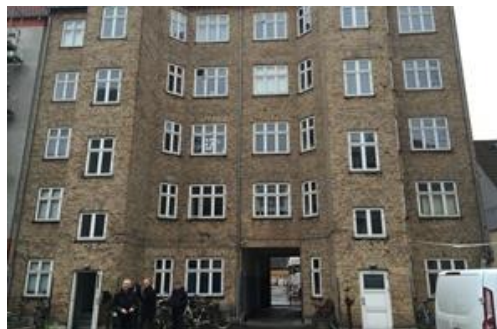
København Ø – Viborggade 45-47 Byggeår 1932 21 lejligheder og 3 erhverv fordelt på 1.598 m 2
