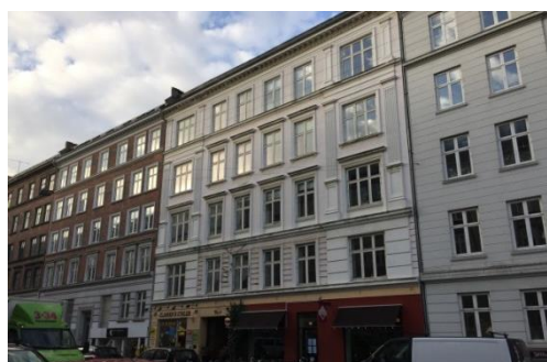
København Ø – Classensgade 11 A-G Byggeår 1892 14 lejligheder og 9 erhverv fordelt på 3.001 m 2
