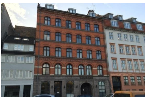
København K – Gothersgade 99-101 Byggeår 1892 14 boliger og 5 erhverv fordelt på 2.540 m 2
