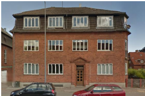
Hellerup – Bernstorffsvej 78-80/Gjøringsvej 16 Byggeår 1928/1929 15 boliger og 1 erhverv fordelt på 2.032 m 2
