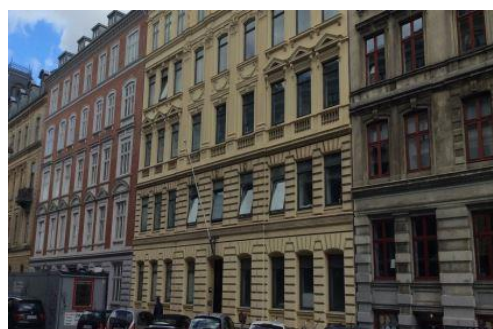
København K – Vendersgade 24 Byggeår 1879 10 boliger fordelt på 1.669 m 2
