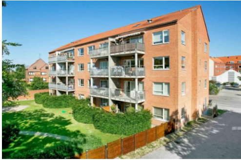
Vanløse – Rosenlunds Allé 11-13 Byggeår 2004 16 lejligheder fordelt på 1.488 m 2
