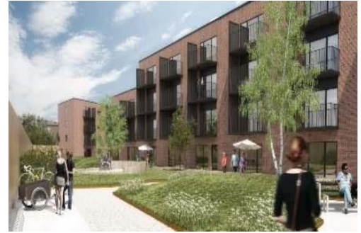
Valby – Pakkerivej 1 (Allé Huset) Byggeår 2019 139 lejligheder og 5 erhverv fordelt på 15.192 m 2
