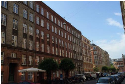
København V – Mysundegade 20-22 Byggeår 1895 23 boliger fordelt på 1.266 m 2
