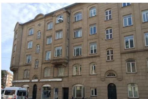
Valby – Rughavevej 1-3 Byggeår 1906 18 boliger og 1 erhverv fordelt på 1.925m 2
