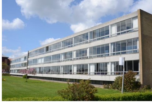
Kolding – Svendborgvej 1-11 Byggeår 1971 51 boliger fordelt på 4.056 m 2
