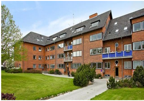
Rungsted Kyst – Rungstedvej 61-69 Byggeår 1939 38 boliger og 1 erhverv fordelt på 3.868 m 2
