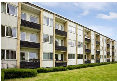
Hørsholm – Skydehøjsgården Byggeår 1960 50 boliger fordelt på 3.790 m 2
