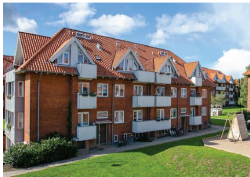
Fredericia – Friggsvej 15 Byggeår 1949 115 boliger og 3 erhverv fordelt på 8.768 m 2
