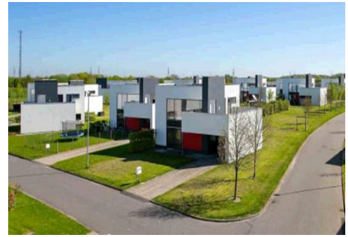
Fredericia – Lucinaborg Byggeår 2008/2010 30 boliger fordelt på 4.215 m 2
