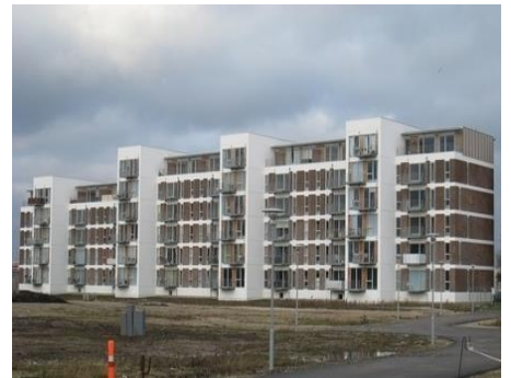
Vallensbæk Strand - Rosenfeldtvej 18-34 Byggeår 2011 104 boliger fordelt på 10.150 m 2
