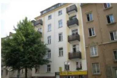
Goebenstrasse 32 Byggeår 1953 18 lejligheder og 2 erhverv fordelt på 1.074 m 2
