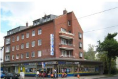
Kalkumer Strasse 30 Byggeår 1959 11 lejligheder og 2 erhverv fordelt på 1.164 m 2
