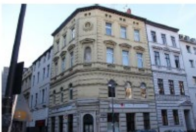
Hildebold Platz 1a Byggeår 1890 8 lejligheder og 1 erhverv fordelt på 490 m 2
