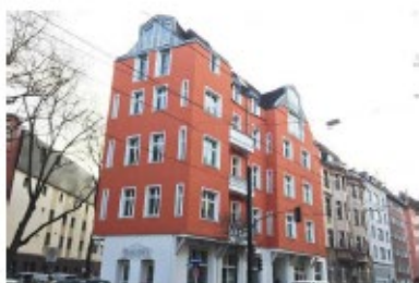
Helmholtzstrasse 2 Byggeår 1962 16 lejligheder og 2 erhverv fordelt på 1.108 m 2
