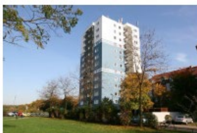
Wöhlerstrasse 14 Byggeår 1970 48 lejligheder fordelt på 3.002 m 2
