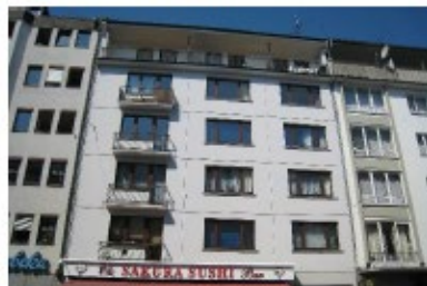
Montzstrasse 24-26 Byggeår 1959 21 lejligheder og 2 erhverv fordelt på 2.122 m 2
