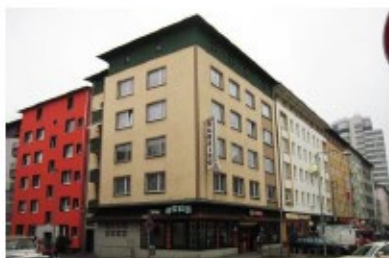
Escherstrasse 2A / Lange Laube Byggeår 1957 9 lejligheder og 1 erhverv fordelt på 864 m 2
