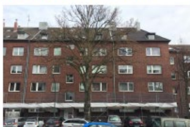
Sternwartstrasse 6-8 Byggeår 1938 23 lejligheder fordelt på 1.227 m 2
