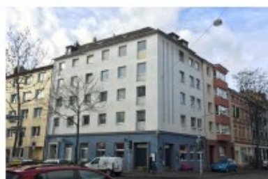
Weissenburgstrasse 18 Byggeår 1951 13 lejligheder og 1 erhverv fordelt på 803 m 2
