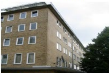
Louise-Schroeder-Strasse 27 Byggeår 1958 10 lejligheder og 2 erhverv fordelt på 759 m 2
