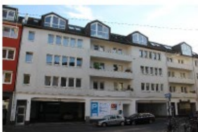
Waisenhausgasse 25-27 Byggeår 1955 33 lejligheder fordelt på 2.424 m 2
