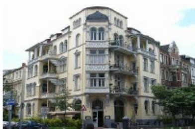
Bödelkerstrasse 43 Byggeår 1890 5 lejligheder og 1 erhverv fordelt på 846 m 2
