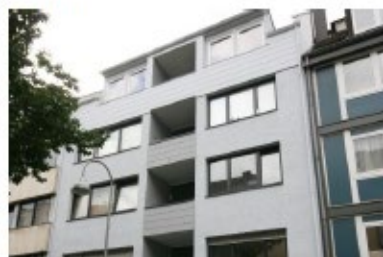
Gustav Strasse 15 Byggeår 1981 14 lejligheder fordelt på 600 m 2
