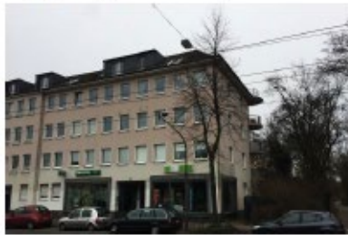
Kalkumer Strasse 32-42 Byggeår 1954 51 lejligheder og 6 erhverv fordelt på 3.934 m 2
