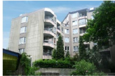
Helmholtzstrasse 21-22 Byggeår 1989 20 lejligheder og 2 erhverv fordelt på 1.674 m 2
