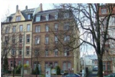
Mörfelder Landstrasse 106 Byggeår 1856 10 lejligheder og 1 erhverv fordelt på 970 m 2
