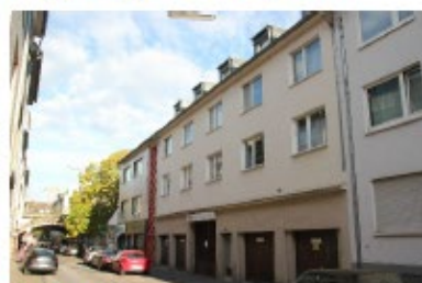
Plankgasse 40 Byggeår 1970 10 lejligheder og 1 erhverv fordelt på 929 m 2
