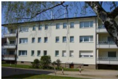
Geschwister-Scholl-Strasse 18 Byggear 1956 24 lejligheder fordelt på 1.269 m 2
