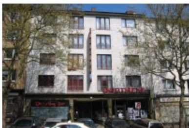
Nobistor 36 Byggeår 1905 10 lejligheder og 2 erhverv fordelt på 972 m 2
