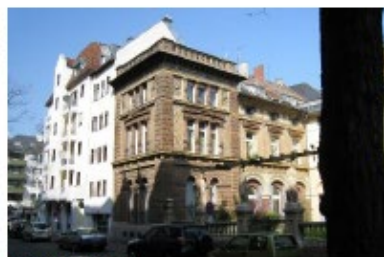
Wörthstrasse 4-6 Byggeår 1878 17 lejligheder fordelt på 1.381 m 2
