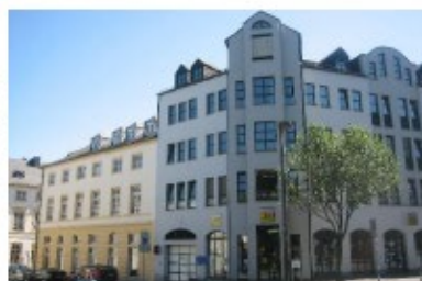
Weisshengasse 10, Weihergarten 11 Byggeår 1954 16 lejligheder og 12 erhverv fordelt på 2.531 m 2
