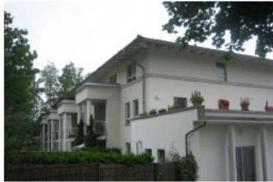
Grünfließler Gang 5,7,13,31 Byggeår 1997 24 lejligheder fordelt på 1.920 m 2
