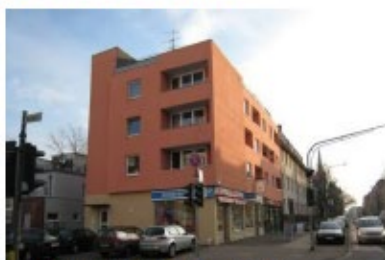
Subbelrather Strasse 314/ Halmstrasse 2 Byggeår 1970 12 lejligheder og 3 erhverv fordelt på 970 m 2
