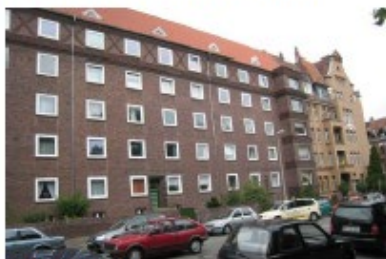
Weckenstrasse 20 Byggeår 1960 9 lejligheder og 1 erhverv fordelt på 591 m 2
