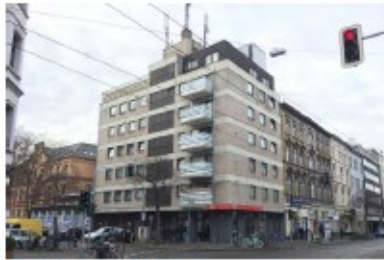
Kronprinzenstrasse 105a Byggeår 1977 16 lejligheder og 1 erhverv fordelt på 1.067 m 2
