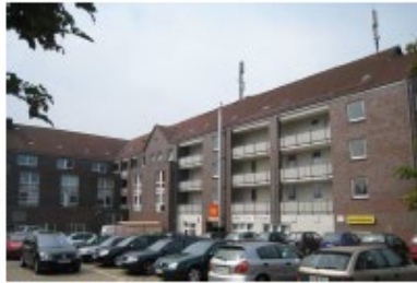
Tresckowstrasse 187 / Plettenbergstrasse 22 Byggeår 1992 26 lejligheder og 12 erhverv fordelt på 3.577 m 2
