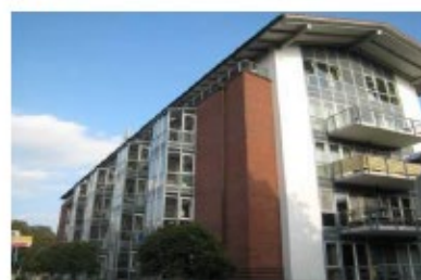
Bramfelder Chaussee 60-62 Byggeår 1997 26 lejligheder og 2 erhverv fordelt på 1.908 m 2
