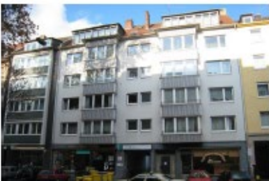
Fürstenwall 200 Byggeår 1955 15 lejligheder og 3 erhverv fordelt på 1.588 m 2
