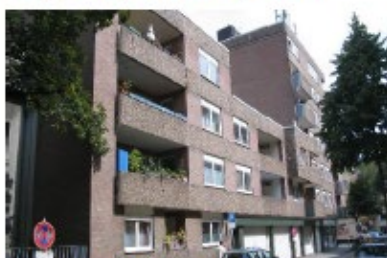
Neusser Strasse 169 / Holbeinstrasse 2 Byggeår 1971 16 lejligheder og 1 erhverv fordelt på 1.150 m 2
