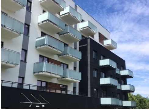
Szczęśliwica 1 Byggeår 2018 39 boliger og 2 erhverv fordelt på 1.825 m 2
