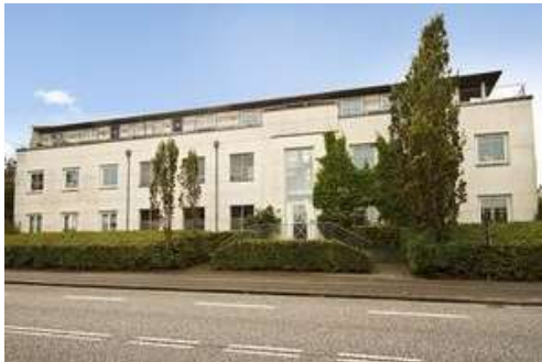
Hørsholm - Rungstedtsvej 4 Byggeår 1996 18 boliger fordelt på 1.814 m 2
