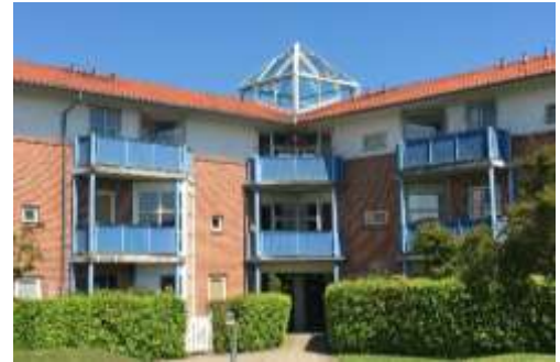
Virum - Lavendelhaven 16-86 Byggeår 1986 og 1989 128 boliger fordelt på 10.800 m 2
