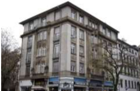
Petersstrasse 2 Byggeår 1912 8 lejligheder og 4 erhverv fordelt på 1.294 m 2
