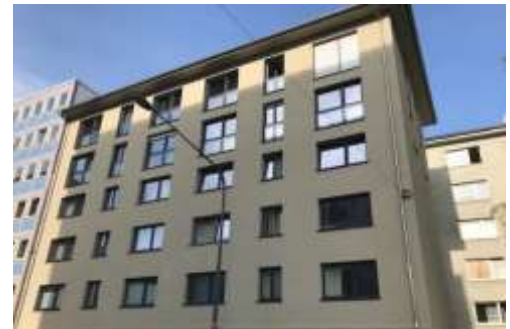
Langestr. 15 / Rechneigraben 1-5 / Schützenstraße 14 Byggeår 1956 54 lejligheder og 6 erhverv fordelt på 4.352 m 2
