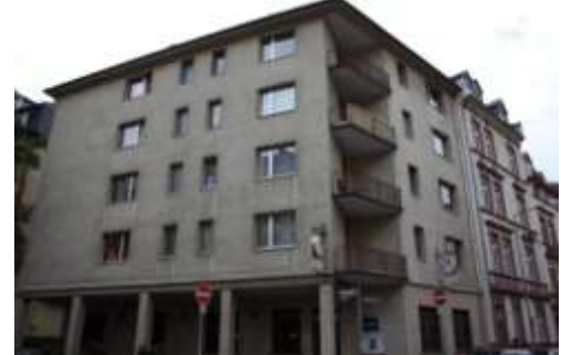
Ringelstrasse 23 Byggeår 1956 11 lejligheder og 1 erhverv fordelt på 692 m 2
