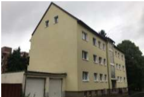
Lange Strasse 3 Byggeår 1963 13 lejligheder fordelt på 701 m 2
