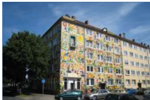
Grenzweg 12 Byggeår 1955 20 lejligheder og 1 erhverv fordelt på 1.056 m 2
