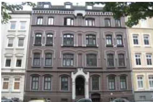
Woltmannstrasse 16 Byggeår 1900 9 lejligheder fordelt på 853 m 2
