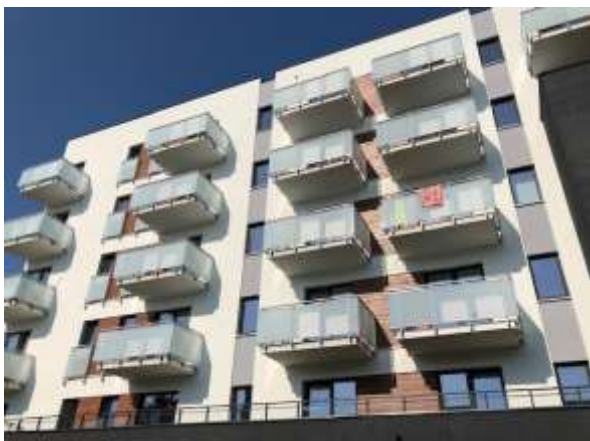
Den ny opførte ejendom på Szcześniewicka
