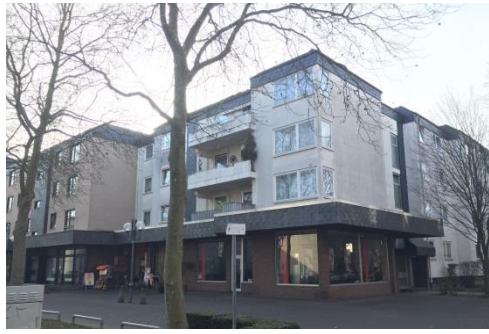
Borsigallee 14-20 Byggeår 1981 47 lejligheder og 2 erhverv fordelt på 3.047 m 2
