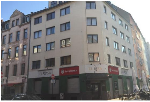
Alteburger Strasse 1 Byggeår 1957 13 lejligheder og 1 erhverv fordelt på 809 m 2
