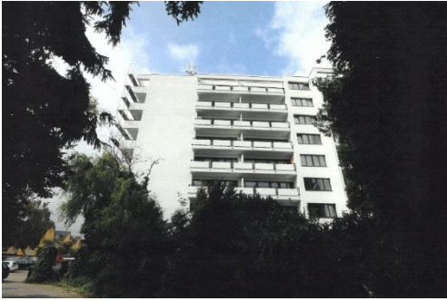
Servatiusstr. 69-73 Byggeår 1971 151 lejligheder og 2 erhverv fordelt på 14.583 m 2
