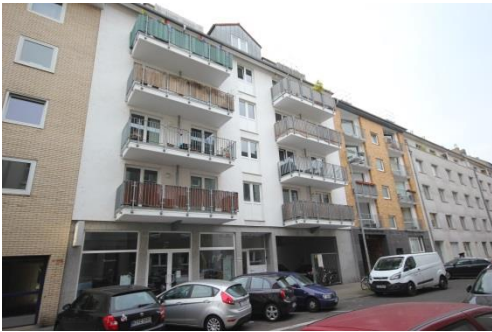
Wormser Strasse 41-43 Byggeår 2002 19 lejligheder og 1 erhverv fordelt på 1.441 m 2
