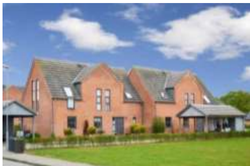
Odense – Over-Holluf-Toften 33 m.fl. Byggeår 2007-2011 19 boliger fordelt på 2.990m 2
