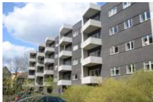
Odense – Klosterbakken 20 A-G Byggeår 2008 67 boliger fordelt på 7.166 m 2
