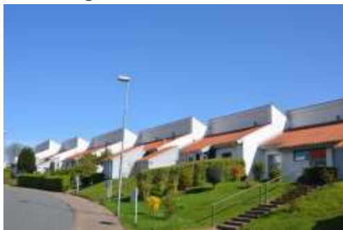
Svendborg – Kogtvedhøj 3-145 Byggeår 1990 120 boliger fordelt på 9.153m 2
