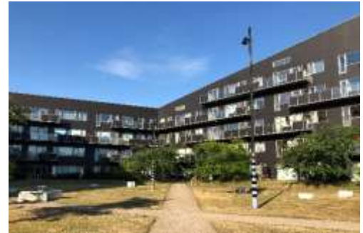
København NV – Gråspurvevej 3-47 Byggeår 2009 134 boliger fordelt på 12.157 m 2
