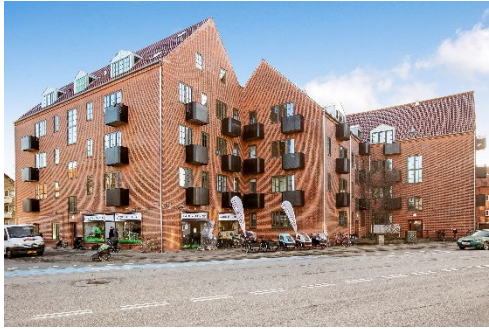
Sallingevej 37-39 – Vanløse Byggeår 1939 53 boliger og 1 erhverv fordelt på 3.720 m 2
