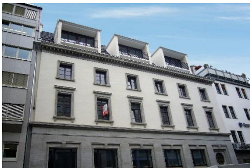
Luisenstrasse 21 Byggeår 1900 15 lejligheder og 3 erhverv fordelt på 2.497 m 2
