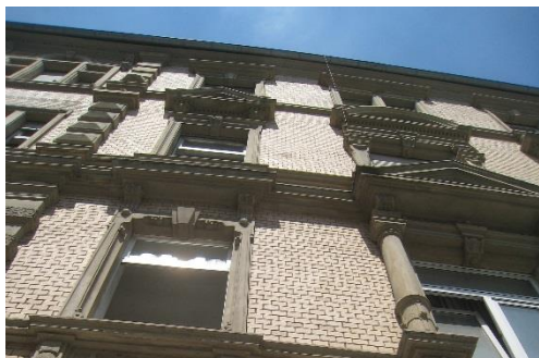
Luisenstrasse 17 Byggeår 1900 16 lejligheder og 2 erhverv fordelt på 1.452 m 2
