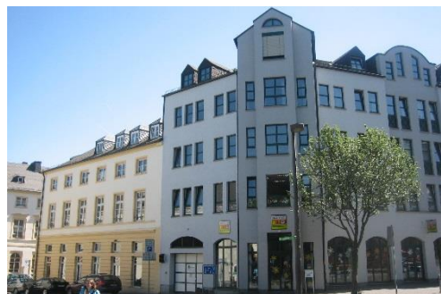
Weissliliengasse 10, Weihergarten 11 Byggeår 1954 16 lejligheder og 12 erhverv fordelt på 2.531 m 2
