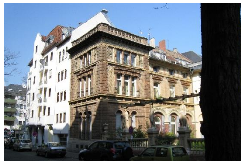
Wörthstrasse 4-6 Byggeår 1876 17 lejligheder fordelt på 1.381 m 2
