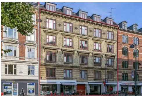
København K – Ndr. Frihavsgade 43-43A Byggeår 1893 9 boliger og 4 erhverv fordelt på 1.189 m 2
