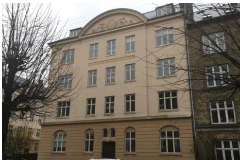
København Ø – Helsingborggade 8-10 Byggeår 1905 56 boliger fordelt på 3.829 m 2
