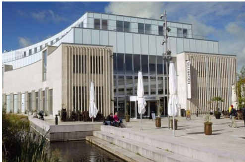
Frederikssund - Sillebroen Byggeår 2010 34 boliger og 2 erhverv fordelt på 2.856 m 2
