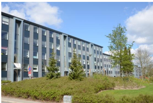
Randers – Engboulevarden 7-53 Byggeår 1969 116 boliger fordelt på 10.279m 2
