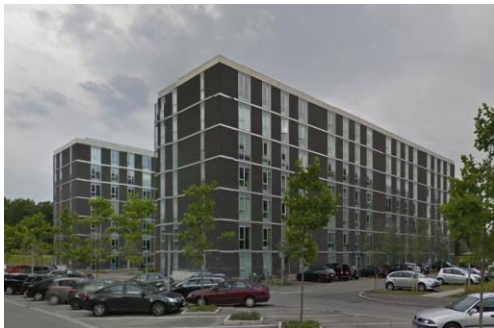
Søborg - Gyngmose Parkvej 6 A-C Byggeår 2012 42 boliger fordelt på 4.102m 2
