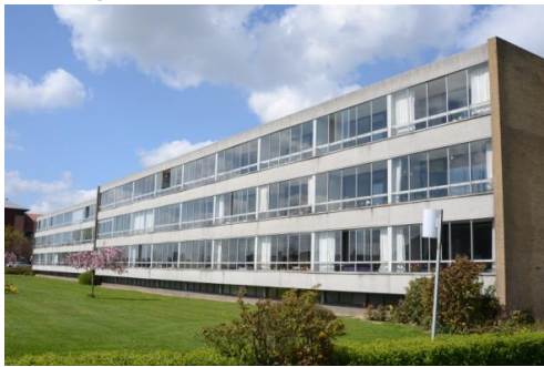
Kolding – Svendborgvej 1-11 Byggeår 1971 51 boliger fordelt på 4.056 m 2
