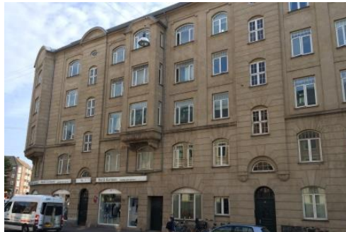
Valby - Rughavevej 1-3 Byggeår 1906 17 boliger og 3 erhverv fordelt på 1.925m 2
