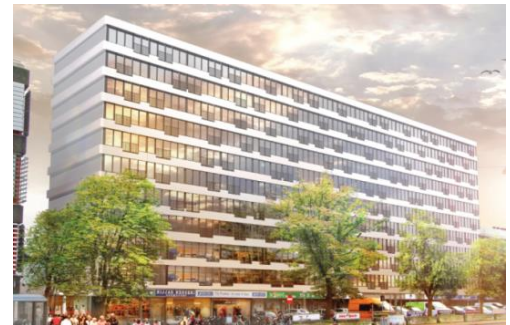
København Ø – Lyngbyvej 32 Byggeår 1972 74 boliger fordelt på 6.163 m 2
