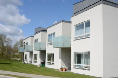
Aarhus, Højbjerg - Emiliedalsvej Byggeår 2012 26 boliger fordelt på 2.390 m 2
