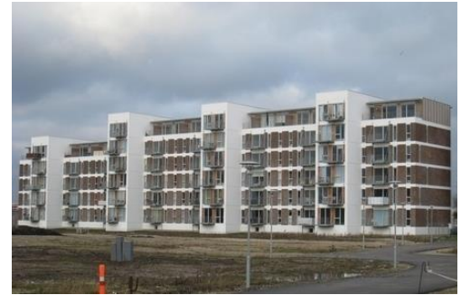
Vallensbæk Strand - Rosenfeldtvej 18-24+30-34 Byggeår 2011 104 lejligheder fordelt på 10.145 m 2
